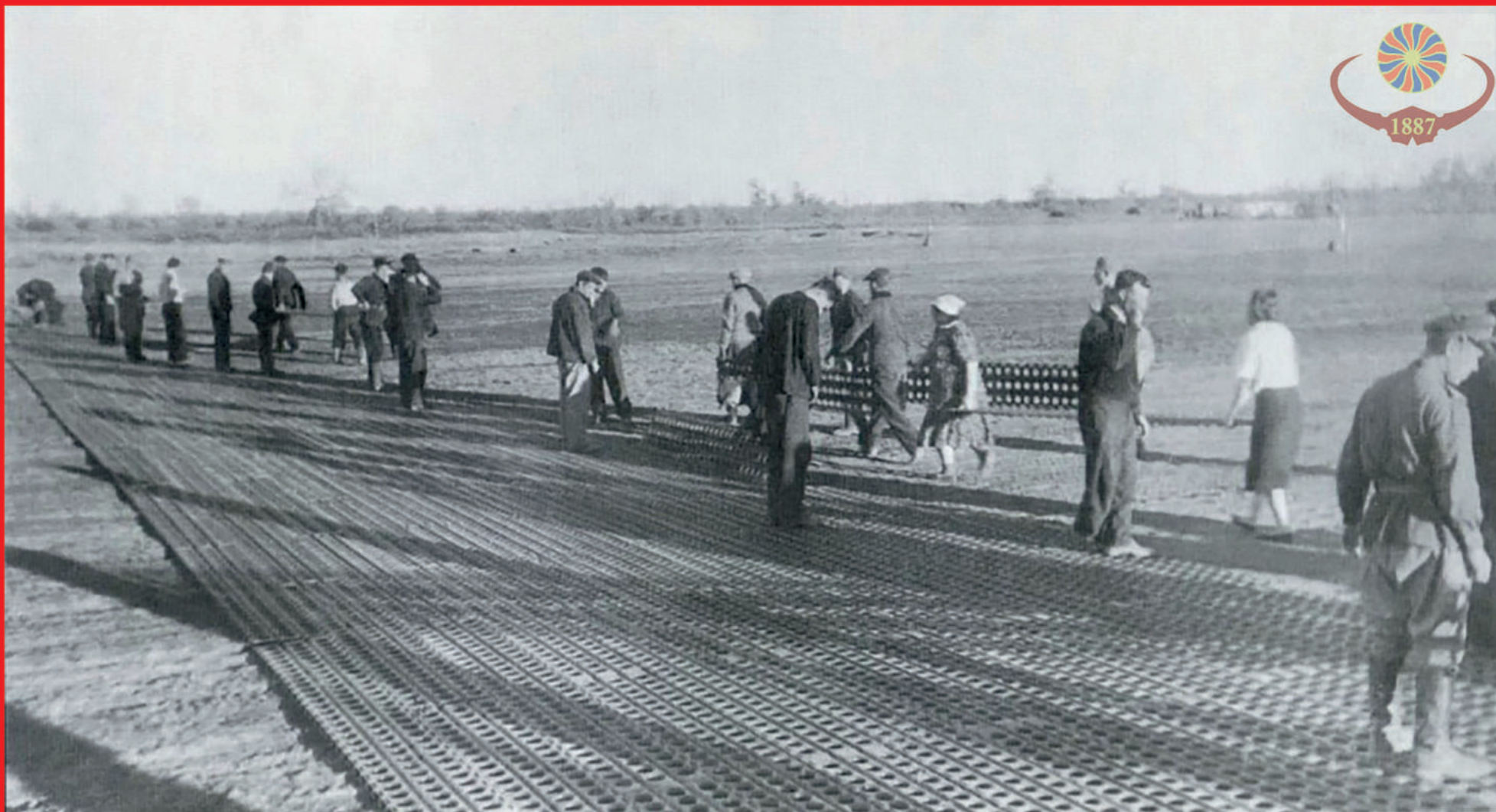
Население и рабочие на укладке металлических секций сборной взлетно-посадочной полосы. АлСиб, 1942 - 1945 гг.
