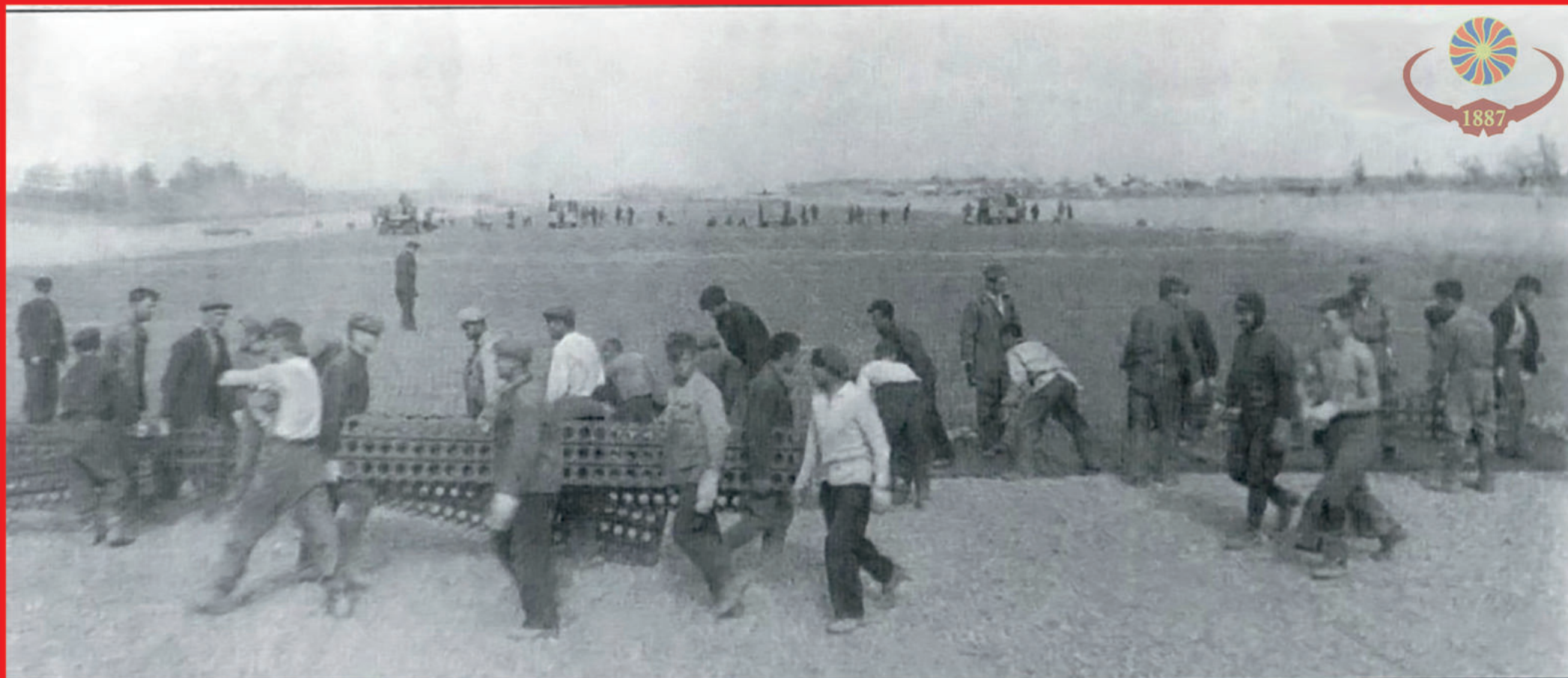
Укладка металлических секций сборной взлетно-посадочной полосы. АлСиб, 1942 - 1945 гг.
